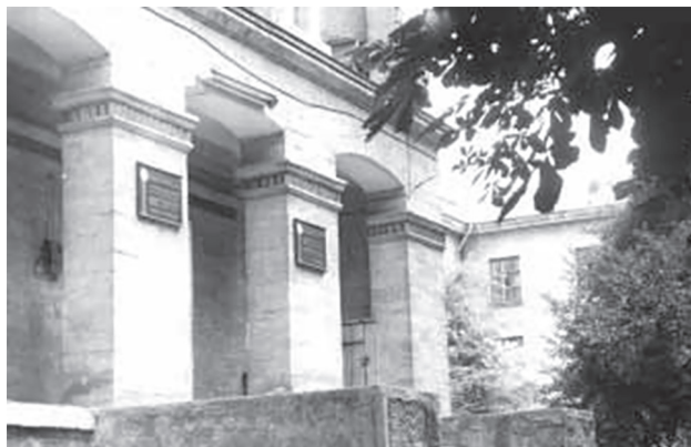
Vedere din față (frontispiciu) a blocului central al IFP de pe str. Decebal, 17. Edificiul a fost dat în exploatare în anul 1956, cu trei ani înainte de fondarea Institutului.
