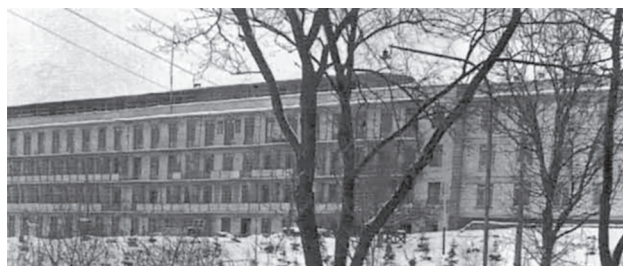
Vorniceni. Bloc curativ construit în anul 1970.
