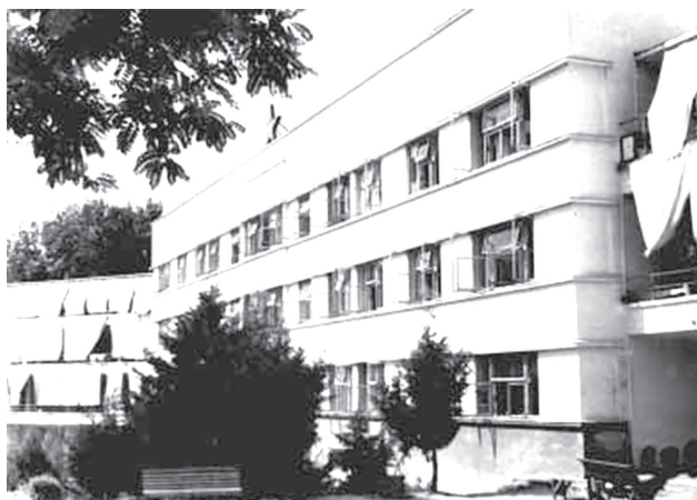
Vorniceni. Bloc curativ, anul 1966.
