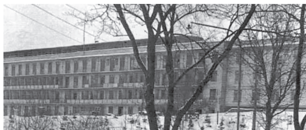
Vorniceni. Bloc curativ construit în anul 1970.
